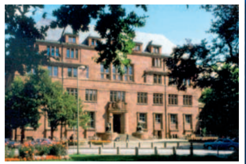
↑ Seit 100 Jahren rot: Das KG I ist aus Sandstein errichtet. Die Architekten haben sich für dieses Baumaterial entschieden, um Freiburgs städtebauliche Tradition aufzugreifen – vor allem den Bezug zum Münster. FOTO: BUHL
