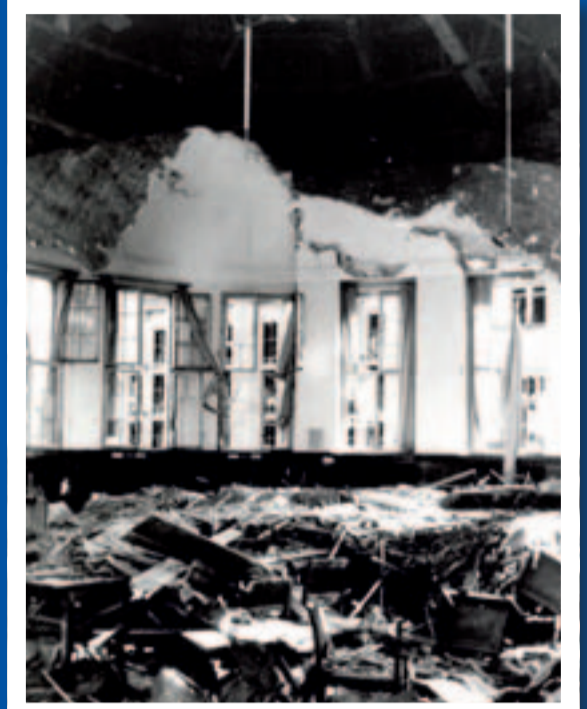
↑ Schutt und Asche: Bei dem Bombenangriff auf Freiburg am 27. November 1944 wird das Kollegienhaus stark beschädigt. FOTO: UNIVERSITÄTSARCHIV
