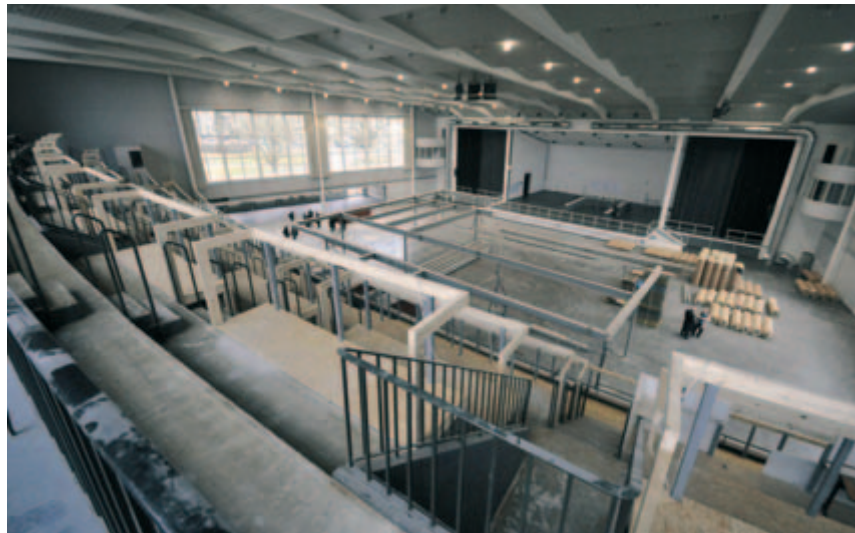
Stadthalle im Umbau
